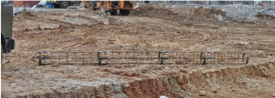
Рис. 1. Готовий арматурний каркас для занурення в ґрунтоцементну палю
