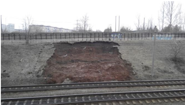
Рис. 1. Ділянка схилу біля залізничної колії швидкісного трамвая: а) – зсув біля північного порталу тунелю (вид збоку); б) – зсув біля північного порталу тунелю (вид з переду)
