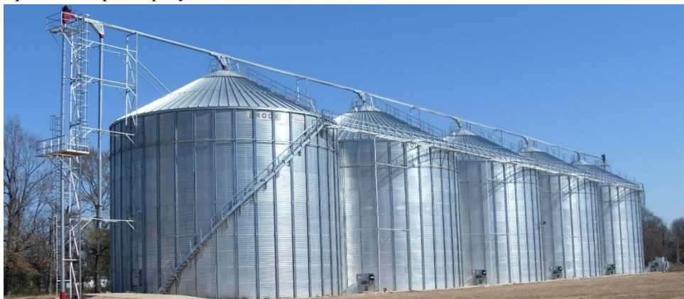
Рис. 1. Загальний вигляд сталевих силосів
