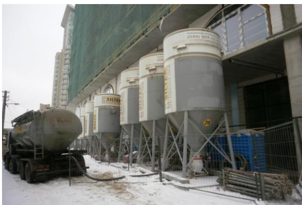
Рис. 7. Заправка силосу сухою сумішшю.
