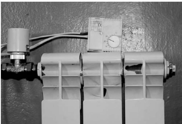
Рис. 4. Положення термостата відносно опалювального приладу: а) положення на висоті H=0 см, ширині A=10 см; б) положення на висоті H=15 см, ширині A=10 см
