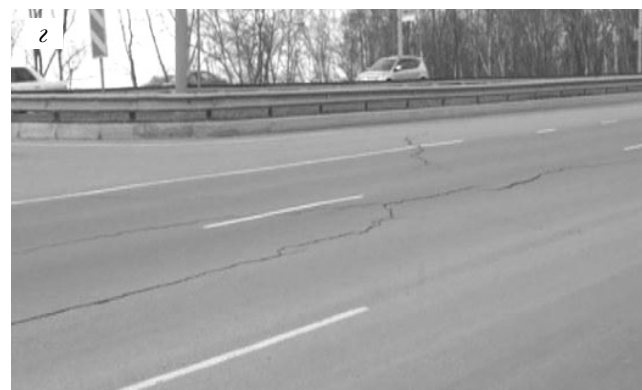
Рис. 1. Види тріщин в дорожніх покриттях: а – відбиті; б – температурні; в – силові; з – технологічні
