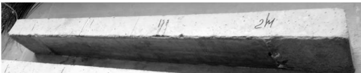
Рисунок 2. Зовнішнє армування залізобетонної балочки шляхом приклеювання одного шару склотканини "Т-13"
