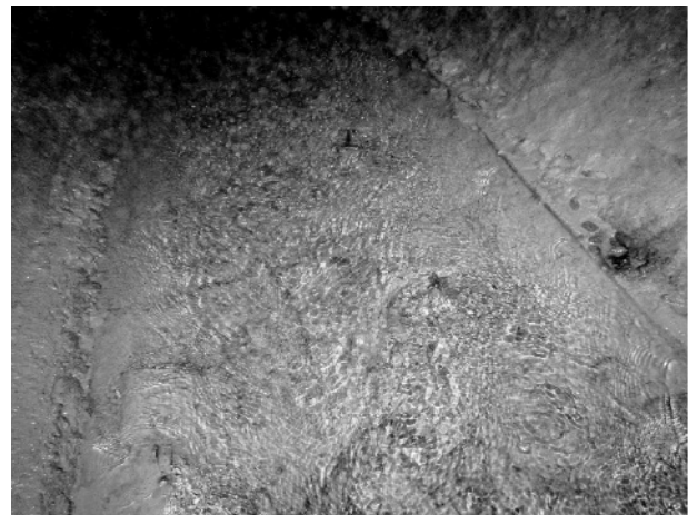
Рис.2 Ділянки з розмитою лотковою частиною тунелю
