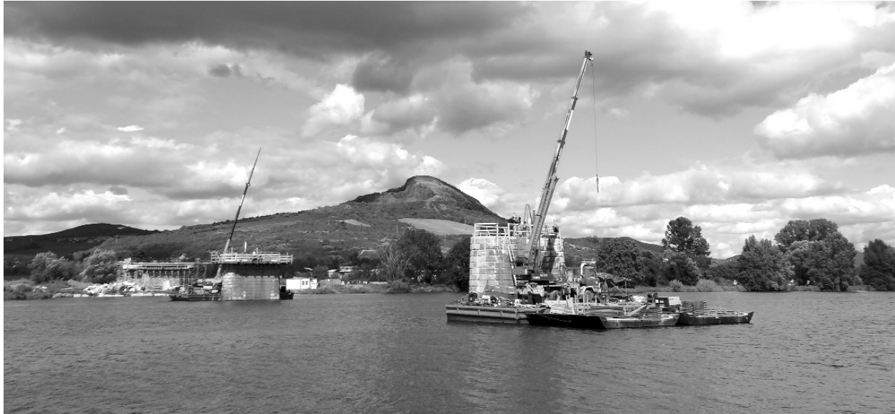
Рис. 1 Загальний вигляд стовпів Р3 і Р4 (далі) від лівого берега Ельби. Всі роботи, у поєднанні з попереднім натягуванням стовпів, проводилися з понтонів, прикріплених до стовпів. На тлі пагорба Radobyl, природного пам'ятника і чіткою домінантою Ловосице і Литомержице. (Foto Minova Bohemia)
