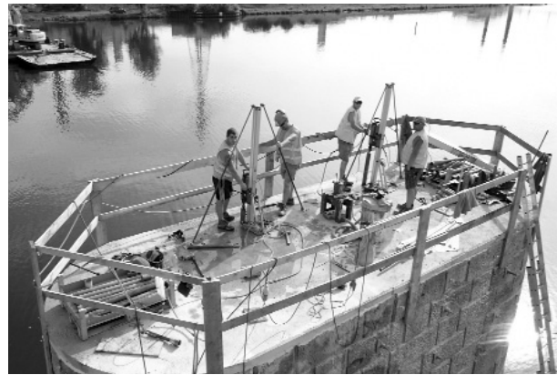
Рис. 3 Буріння проводилося двома екіпажами на кожній опорі. Вигляд "Аерофотознімка" заголовка стовпця Р4 дає уявлення про відносно обмежений доступний робочий простір. Він все більш і більш скорочувався у процесі роботи та підйому анкерних стрижнів.
