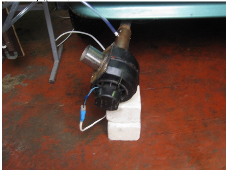
Рис.5. Зовнішній вигляд монтованого вентилятора
