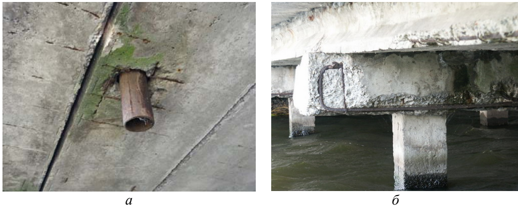
(а) трубка водовідводу та (б) ригель опори і плити проїзної частини моста. Рис. 1 – Стан залізобетонних елементів конструкцій після тривалої експлуатації
