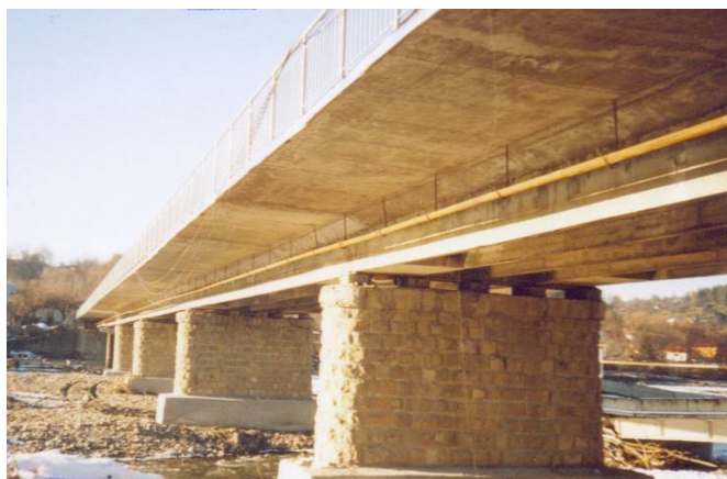
Рис. 2. Загальний вигляд моста після влаштування накладної плити
