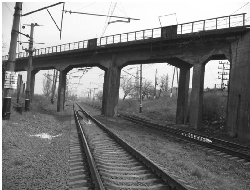
Рис. 2. Общий вид путепровода, расположенного на перегоне ст. Сартана – ст. Сортировочная ОАО МК «Азовсталь»
