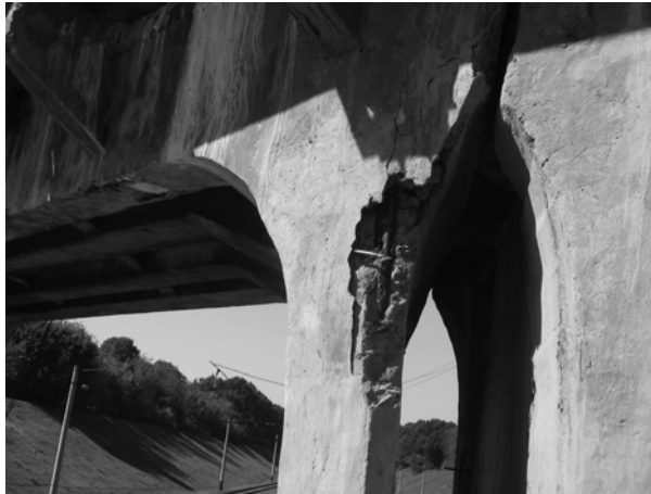
Рис. 4. Повреждение вута и его усиление металлоинъекционной рубашкой
