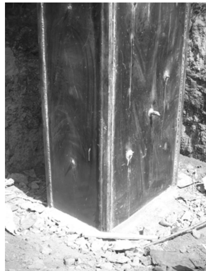
Рис. 5. Повреждения стоек путепровода и их усиление при помощи металлоинъекционной обоймы
