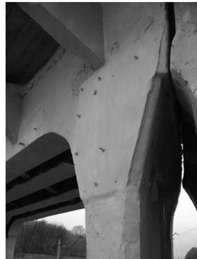
Рис. 4. Повреждение вута и его усиление металлоинъекционной рубашкой
