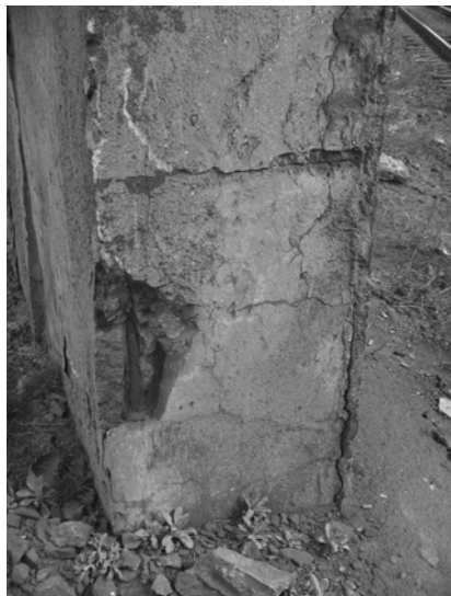
Рис. 5. Повреждения стоек путепровода и их усиление при помощи металлоинъекционной обоймы
