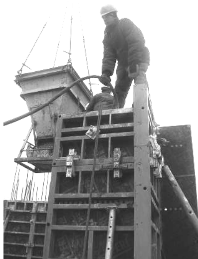
Рис. 1. Виготовлення дослідних фрагментів колон
