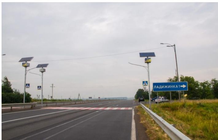
Рисунок 4 – Влаштування зовнішнього освітлення пішохідного переходу біля с. Ладизинка на 230 кілометрі автодороги М-05 Київ – Одеса. [2]
