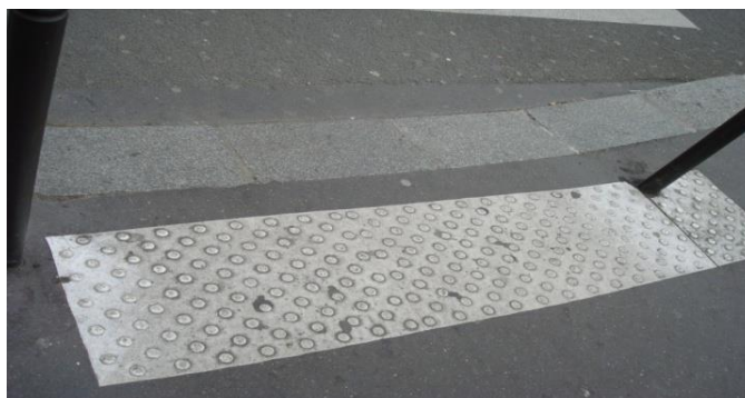
Рисунок 7 – Напрямна доріжка із тактильними орієнтирами, влаштована перед наземним пішохідним переходом
