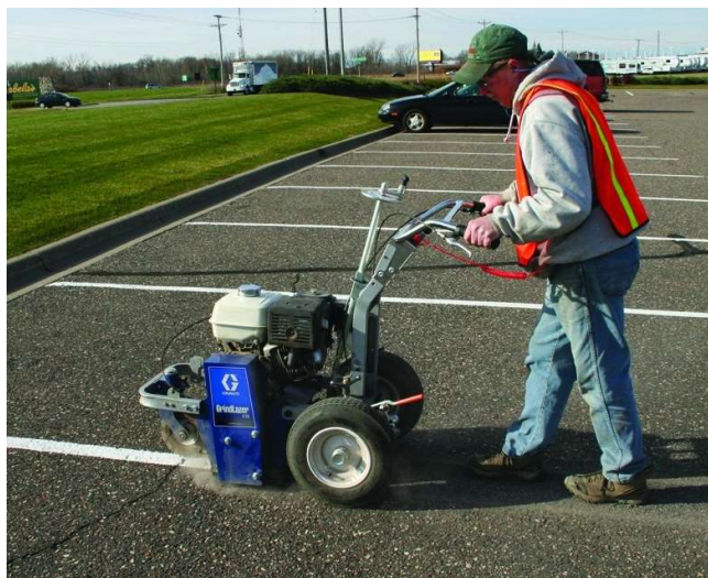
Рисунок 3 - Демаркування дорожньої розмітки машиною GrindLazer
