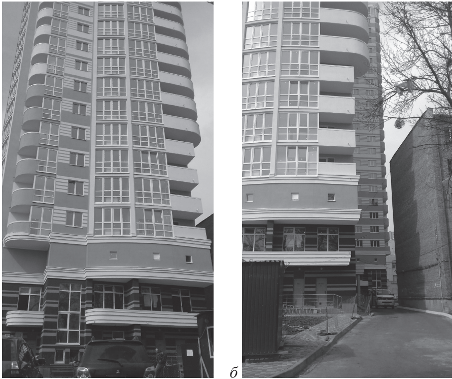
Рис. 1. Житловий будинок по вул. К. Малевича (В. Боженка), 89, в м. Києві: а – зовнішній вигляд з боку вул. К. Малевича; б – вигляд з боку подвір'я
