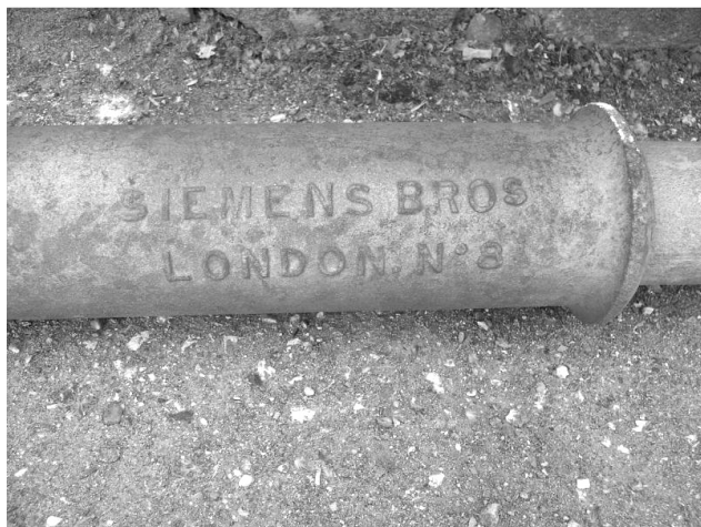
Рис. 5. Основание опоры Индоевропейского телеграфа, найденной в Керчи
