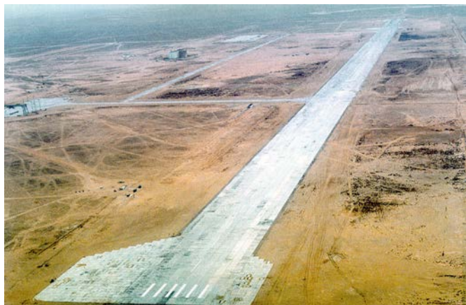
Рис.3. Вид с высоты «птичьего полета» на строящийся посадочный комплекс. 1983-1984
