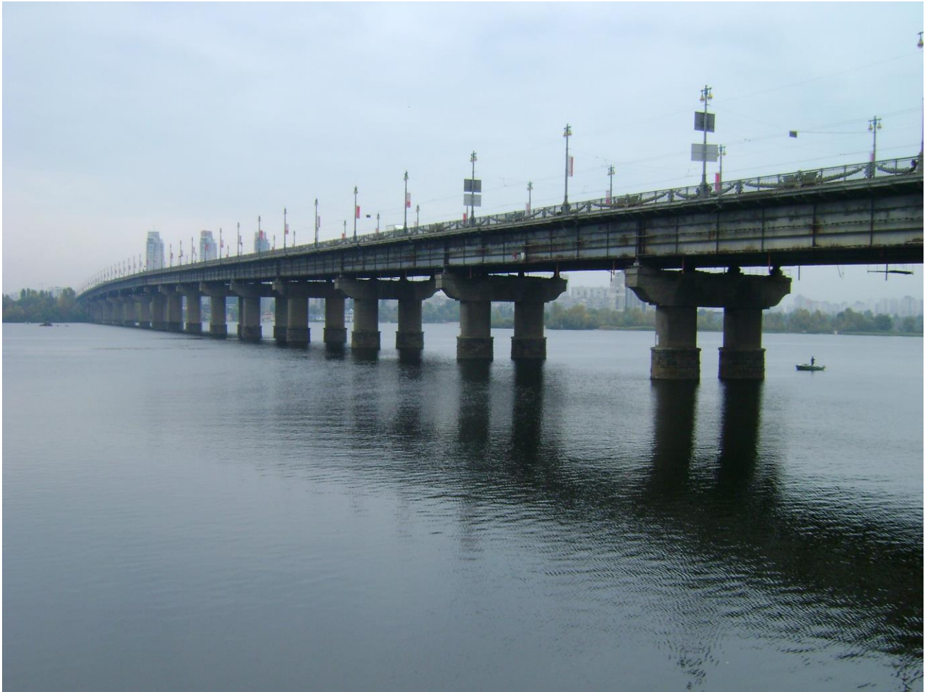
Рис. 4. Міст імені Патона через Дніпро у Києві – перший у світі суцільнозварний міст завдовжки 1543 м. Відкритий 5 листопада 1953 р.
