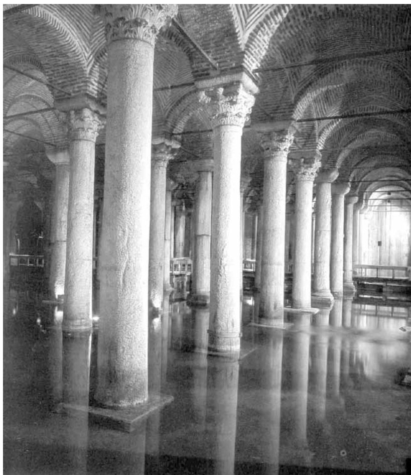
Рис. 9. Ерэбатан-подземное водохранилище Константинополя
