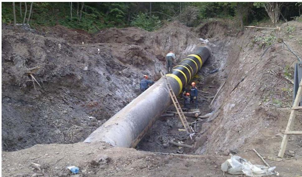
**Рис. 1. Аварія газопроводу у слабко несучому ґрунті**
