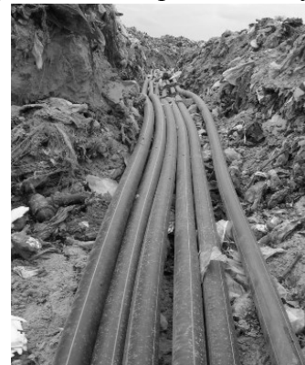
Рис. 7. Прокладання трубопроводів біогазу на полігоні ТПВ
