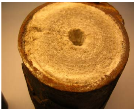
Рис. 1. Отложения солей в котловой трубе
