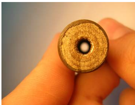
Рис. 2. Отложение солей в трубке бойлера ГВС
