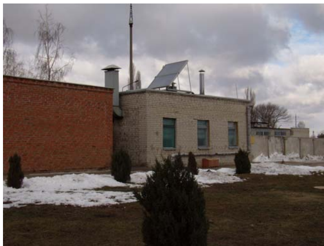
Фото 10. Колектор геліоустановки на покрівлі будинку їдальні
