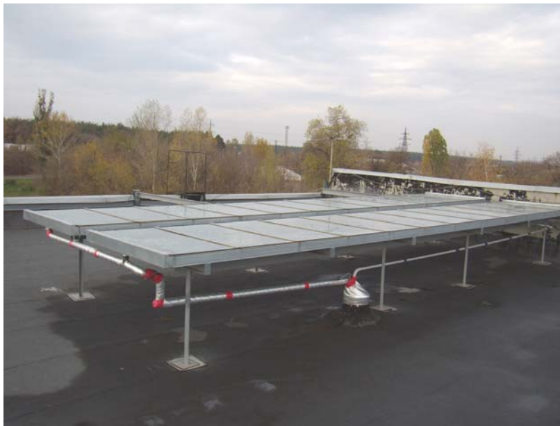
Фото 8. Експериментальна геліоустановка F=24 м 2 .
