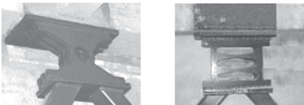
Рис. 3. Способы интегрирования стальных демпферов в структуру здания
