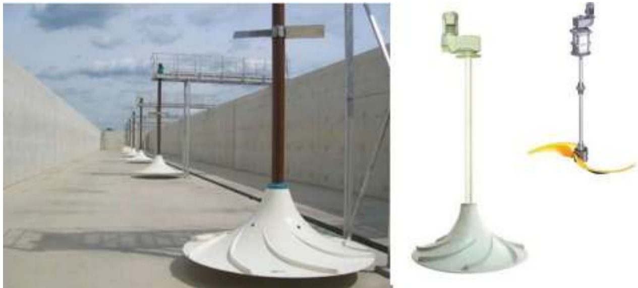
Рис. 3. Мішалки з вертикальним валом виробників: Invent (Німеччина), GSD (Тайвань), Xylem-ITT Flygt (Швеція) [6]
