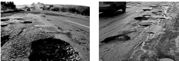
Рисунок 1 – Характер профілю каверн поверхонь автомобільних доріг
