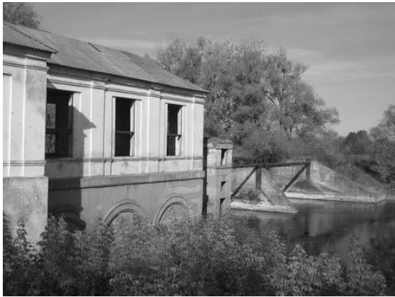
Рисунок 2 – Здание МГЭС и водосливная бетонная гребля на реке Псел
