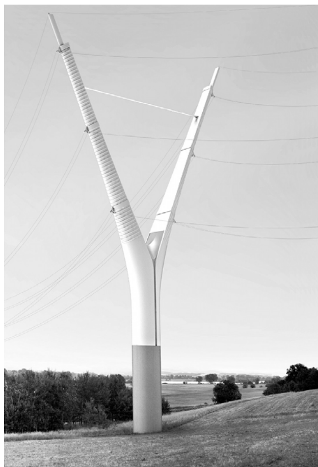
Рисунок 2 – Композитные опоры ВЛ
