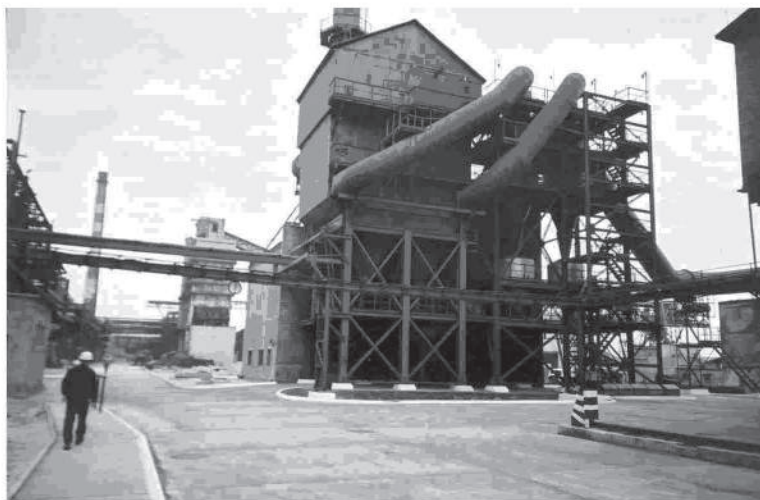
Установка БВК коксовой батареи № 3 на ОАО «Маркохим»
