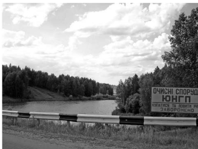
Рис. 5. Сооружения доочистки сточных вод пос. Юльевка – поверхностное биоплато
