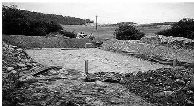
Рис. 1. Фильтрационный блок биоплато
