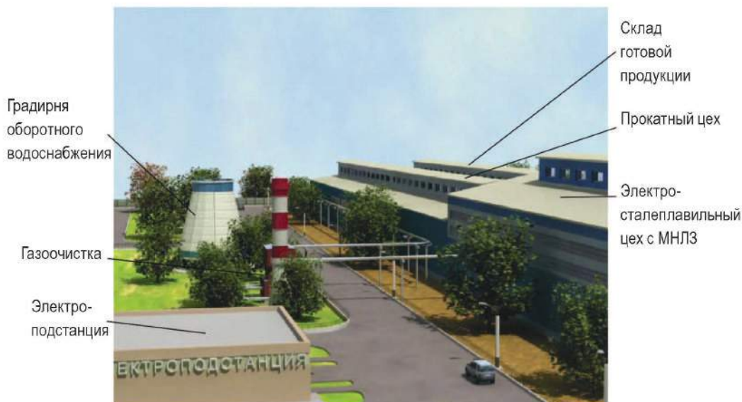
Рисунок 5 – Металлургический микрозавод с объектами инфраструктуры
