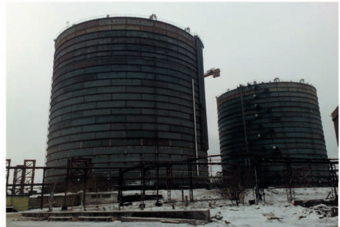
Рисунок 2 – Газгольдеры доменного и коксового газов
