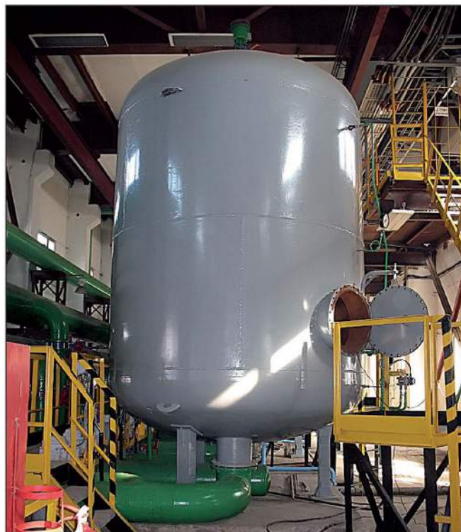
Рисунок 1 – Напорный антрацито-кварцевый фильтр
