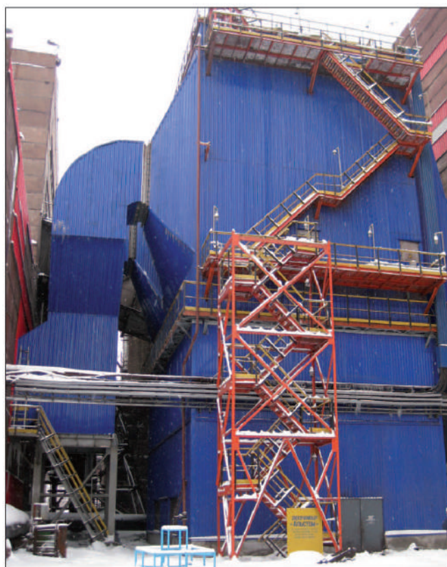
Рисунок 4 – Установка двухпольного двухсекционного электрофильтра
