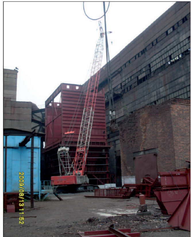
Рисунок 1 – Строительная площадка в начале реконструкции
