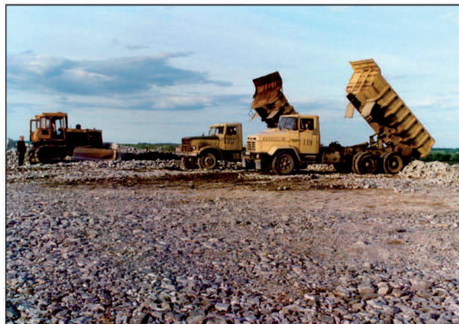
Рисунок 3 – Рекультивационные работы на хвостохранилище ГМЗ г. Желтые Воды
