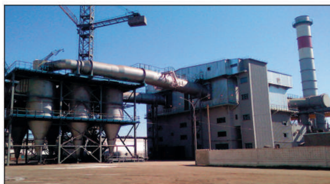
Рисунок 1 – Циклоны ЦП2-4250 и рукавные фильтры ФРИР-7000
