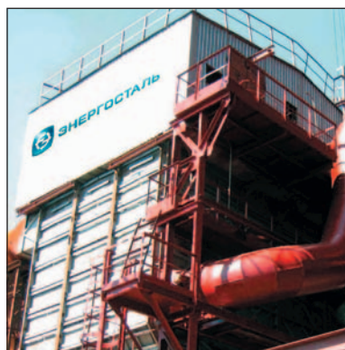
Рисунок 4 – Рукавный фильтр ФРИР в ПАО «Баглейкокс», Украина
