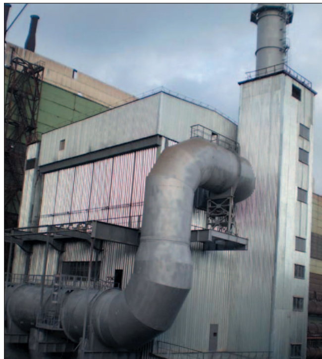
Рисунок 7 – Рукавный фильтр ФРИП в ПАО «Никопольский завод ферросплавов»
