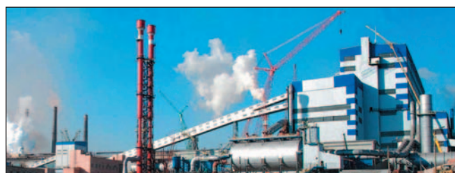
Рисунок 3 – Конвертерный цех ПАО «АМК», построенный по проекту ГП «УкрНТЦ «Энергосталь»
