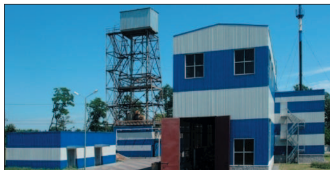
Рисунок 11 – Мусороперерабатывающий завод в г. Люботине Харьковской обл.
