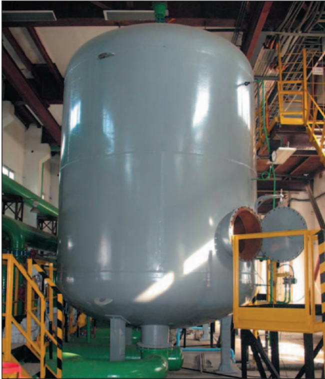
Рисунок 10 – Антрацито-кварцевый фильтр производства ГП «УкрНТЦ «Энергосталь»
