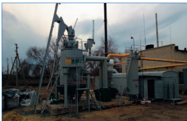
Рисунок 1 – Газогенератор серии ГНД «Теплоэнергогаз» производительностью 2,5 МВт в котельной г. Луганска
