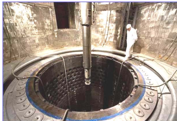
Рис. 9. Загрузка свежего топлива (сборки ТВС) в мощный водо-водяной ядерный реактор типа ВВЭР-1000 (верхняя герметичная защитная крышка реактора снята) [2, 9]
