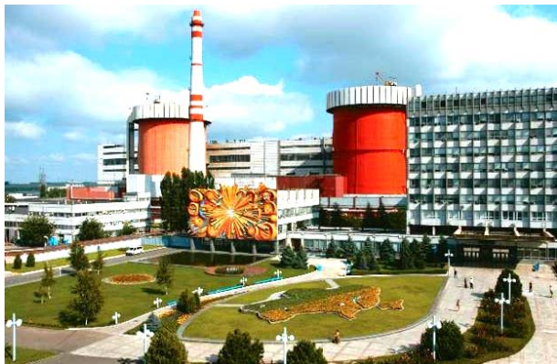
Рис. 11. Общий вид фрагмента Южно-Украинской АЭС суммарной установленной мощностью 3000 МВт (г. Южноукраинск, Николаевская обл., Украина) [17]
