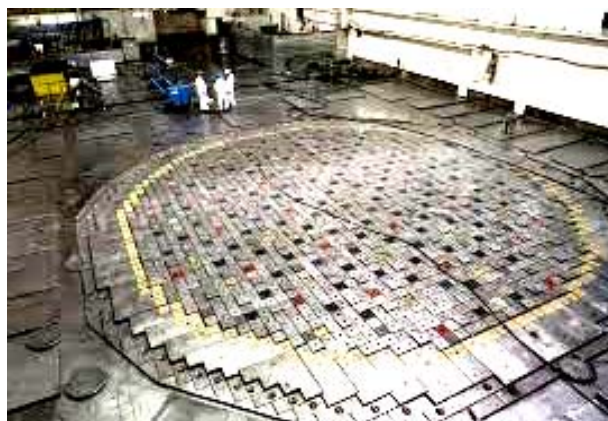
Рис. 7. Общий вид мощного ядерного реактора типа РБМК-1000, установленного в реакторном цеху одного из 4-х эксплуатировавшихся энергоблоков Чернобыльской АЭС (до катастрофы в 1986 г.), со стороны его сборной из отдельных свинцовых блоков верхней защитной крышки [2, 9]
