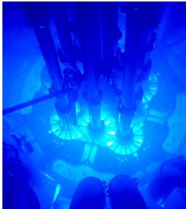
Рис. 5. Редчайший вид активной зоны действующего исследовательского водо-водяного ядерного реактора (в активной зоне этого типа реактора отчетливо наблюдается голубое свечение, вызванное излучением Вавилова-Черенкова) [2]
