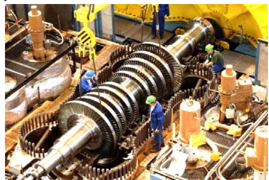
Рис. 4. Монтаж в машинном зале АЭС мощной отечественной паровой турбины ПТ-1000 (справа по оси турбины виден корпус соответствующего турбогенератора) [9]
