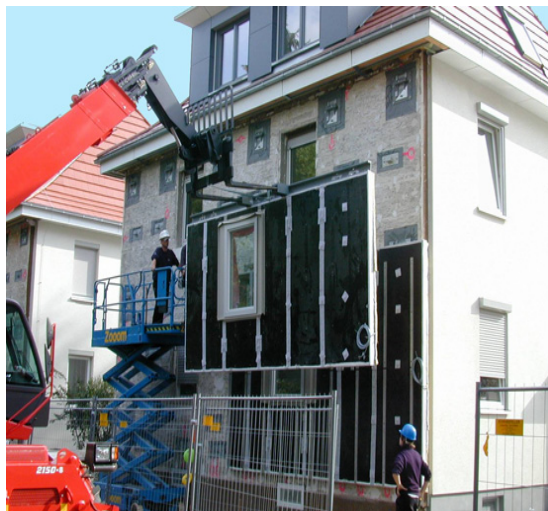
Рис. 5. Утеплення фасадів житлового будинку вакуумними панелями
