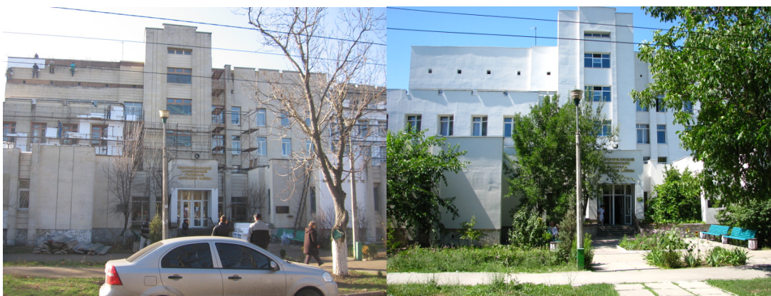
Рис. 2. Санація будівлі, вигляд до і після.
