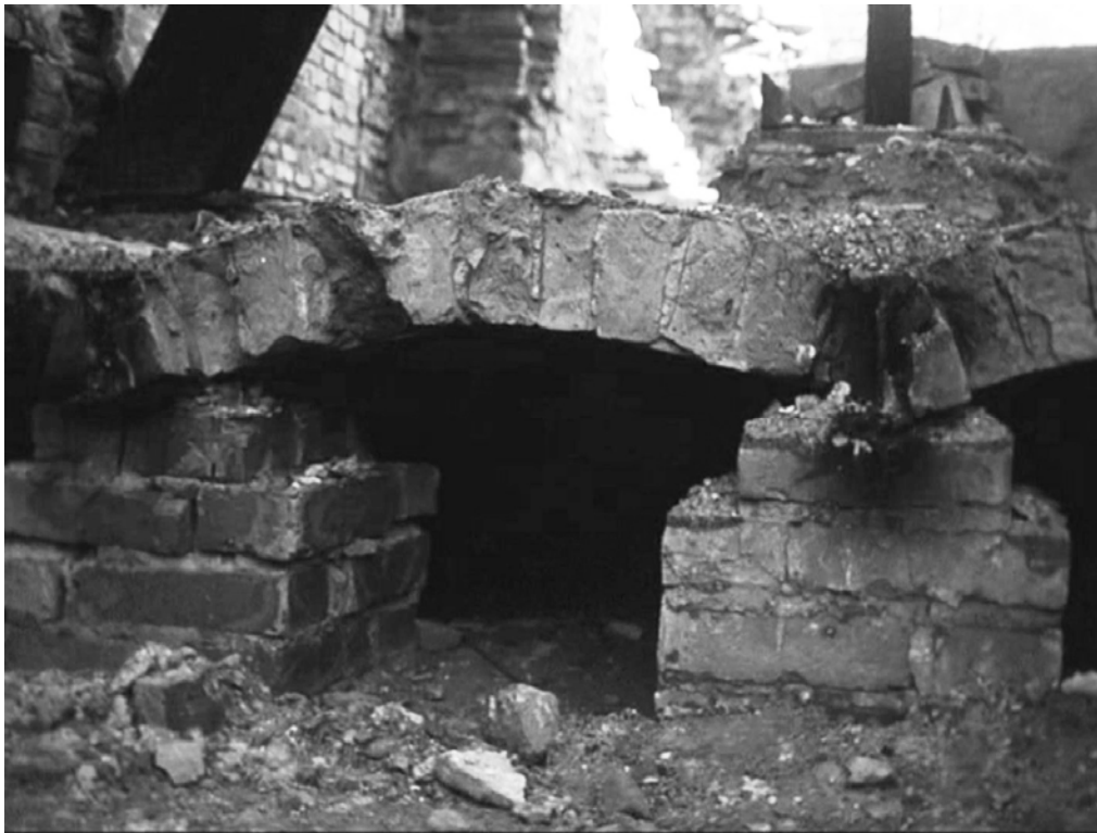
Рис. 4. Фрагмент каналу системи опалення та вентиляції (Фото 1998 р.)
