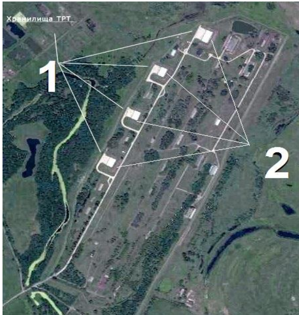
Рис. 2. Общий вид зоны размещения хранилищ твердого ракетного топлива: 1 – хранилище твердого ракетного топлива, 2 – защитный вал
