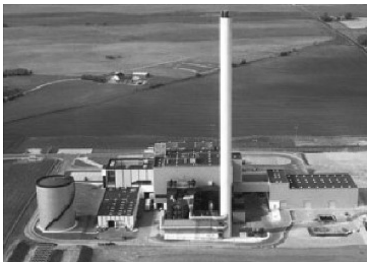
Рис. – Електростанція на біомасі у Данії [2].
