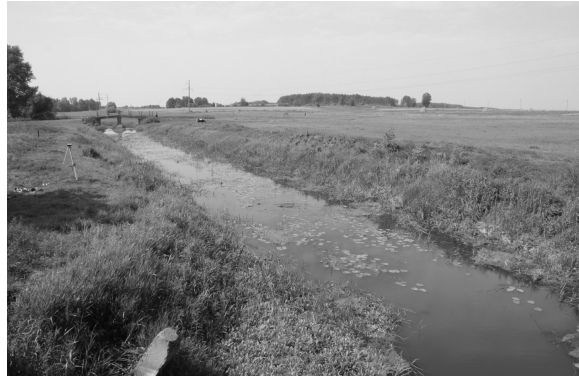
Рис. 4 – ДО № 46 (Lut_vsm_sed_low) с.Сокіл (поганий гідроморфологічний стан, бальний показник стану русла – 5,00 - V – дуже поганий)
