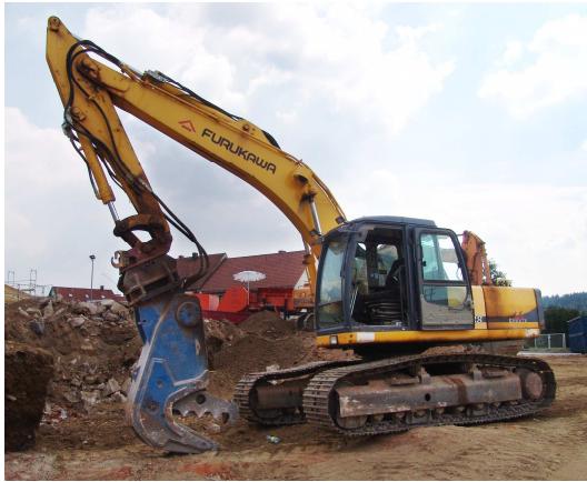
Рис. 12. Універсальний екскаватор із двохщелепним захоплювачем
