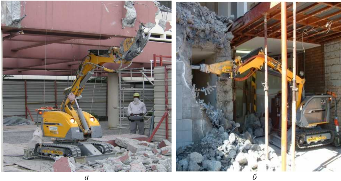
Рис. 2. Будівельні роботи компанії “Brokk” проводять демонтажні роботи: а – робот Brokk 330D з подрібнювачем бетону; б – робот Brokk 160 з гідромолотом
