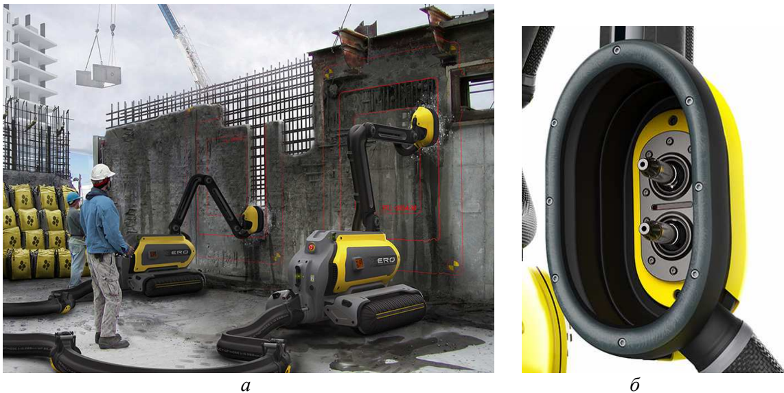
Рис. 5. Утилізація бетонної стіни роботом ERO (а) та вигляд робочого інструменту (б)
