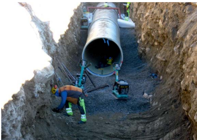
Рис. 2. Монтаж напірного водоводу дериваційної ГЕС Веслефаллет
